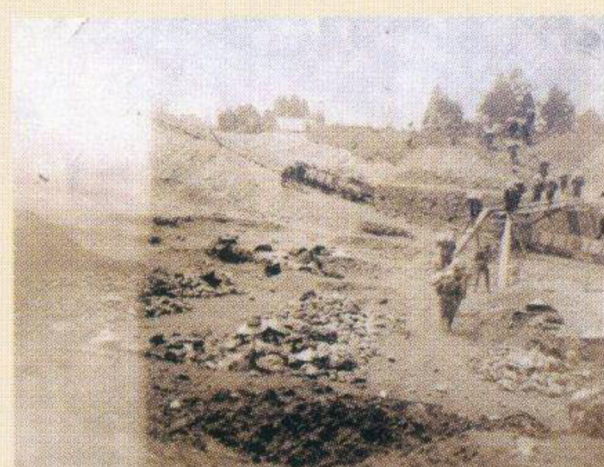
▲工事の様子(大正10年頃)
