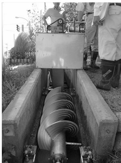
写真2 砺波市立東部小学校に設置された螺旋水車発電機（協同アルミ株式会社製）
