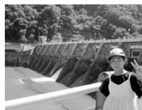
合口ダムの放水のようす
