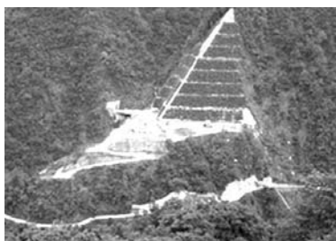
利賀ダム建設現場
