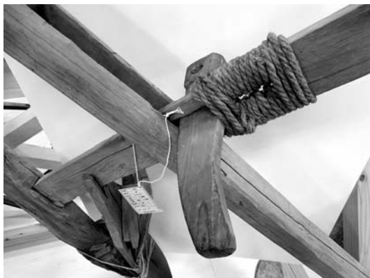
写真9 在来スキ スキ柱と練木の調節部
