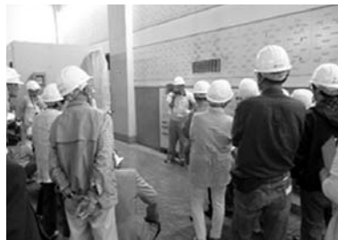
御母衣地下発電所
